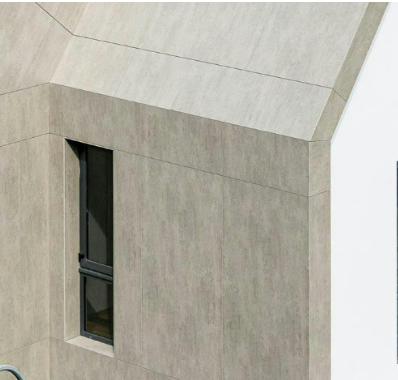
Dekton gevelbeplating voor de begane grond
