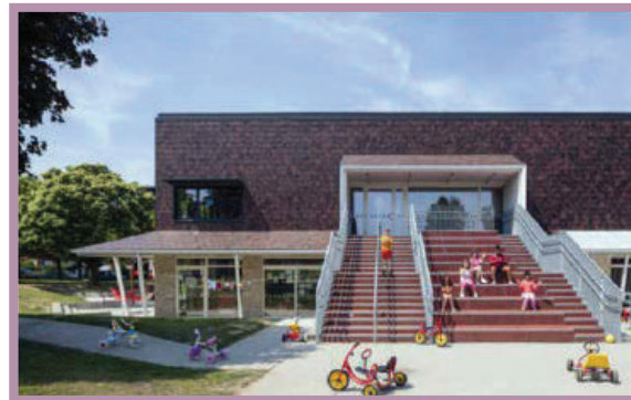
Programma en architectuur verbonden met het plein
