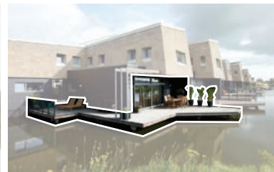
Vlonder als overgang tussen gebouw en water
